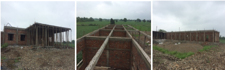
Das College im Bau
